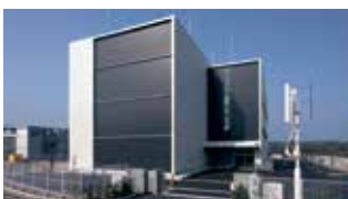
● 岡山データセンター
